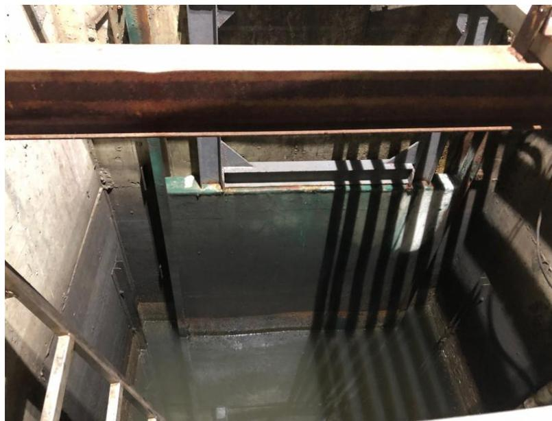
末端雨水井：10m<sup>3</sup>，设有雨水阀门，两台水泵（一备一用）
