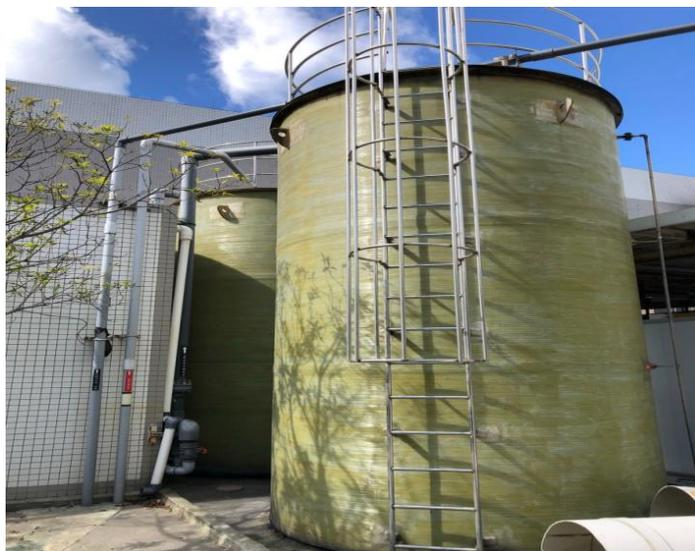
地上应急储罐：应急罐可做应急池功能使用，单个应急罐容积为 $30\text{m}^3$ ，本公司共置备4个应急罐，应急罐总容积为 $120\text{m}^3$
